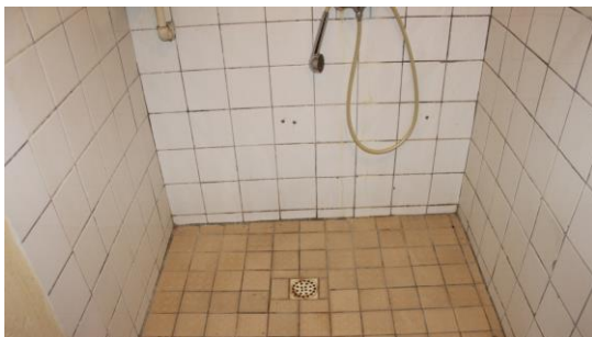
Sprcha v šatni pre zamestnancov práčovne pred rekonštrukciou
