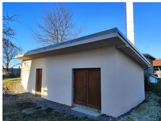
Sklad pri záhrade po rekonštrukcii
